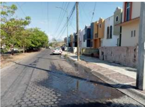
Inspección descarga de aguas grises
